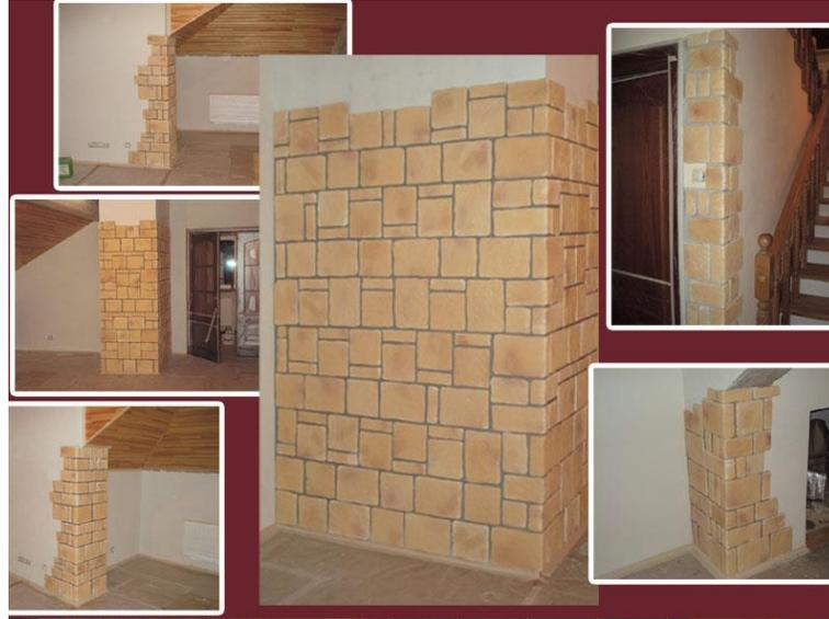
Для создания оригинальных рисунков мозаичной кладки существует большое разнообразие различных типоразмеров (8) плитки. Укладку плитки рекомендуется производить **со швом 1см** для соблюдения кратности длин фрагментов кладки. Для отделки углов служат 6 разных по размерам угловых элементов.
